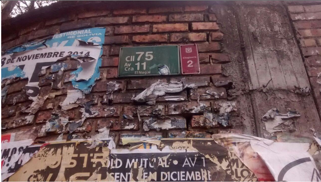
Fotografía No. 6. Elementos instalados en Espacio Público. Operativo en la Localidad de Chapinero, día 08 de Febrero de 2016. Nomenclatura Carrera 11 con Calle 75.
